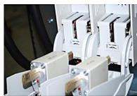
**Parts** 2x NH fuse Recommendations 80 A ⇒ SI 3.0 M-11 100 A ⇒ SI 4.4 M-11 160 A ⇒ SI 6.0 H-11 200 A ⇒ SI 8.0 H-11
